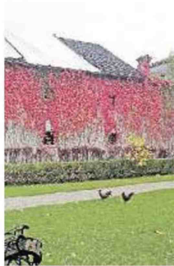
MONUMENTALE I danni al tetto 35 fra 40 e 158 1209 grino
